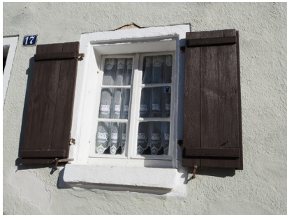
In der Altstadt findet man viele Beispiele für ortstypische historische oder nach historischem Vorbild erneuerte konstruktiv geteilte Fenster mit hölzernen Klappläden.
