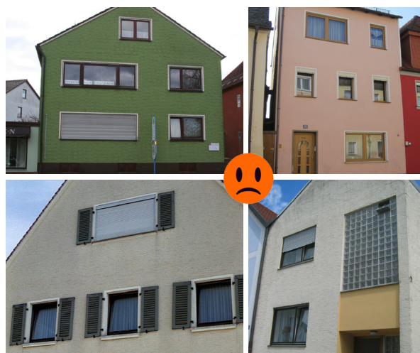
Einzelne liegende Fensterflächen, untypische Fensterteilungen und Glasbausteine stören das Fassadenbild ebenso wie eine bunte Mischung verschiedener Formate.
