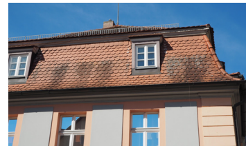
Steile Satteldächer, steile Walmdächer und Mansarddächer gelten als ortstypische Dachformen in der Altstadt.
