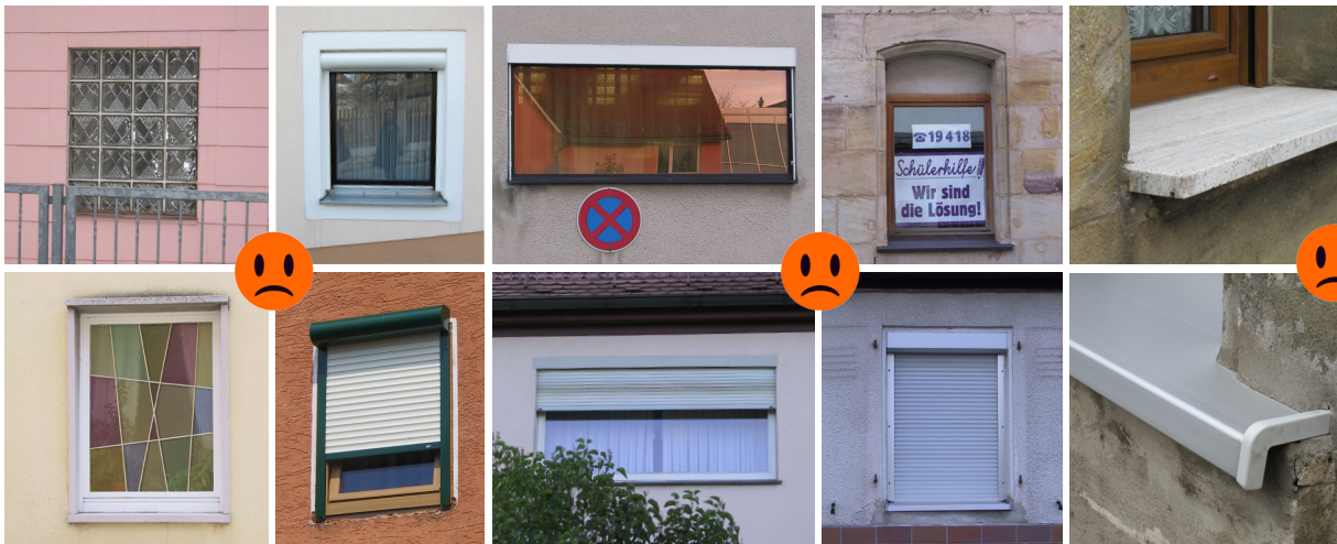
Farbige Glasflächen, Metallsprossen, aufgesetzte Jalousiekästen und liegende ungeteilte Fensterformate sind an historischen Gebäuden untypisch und nicht förderfähig. Falsche Fensterformate in historischen Fensteröffnungen und Fensterbänke aus poliertem Naturstein und Aluminium mit Kunststoffprofilen werden dem Wert historischer Fassaden nicht gerecht.
